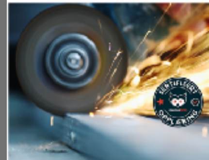
Brannvern ved utførelse av varme arbeider K076
